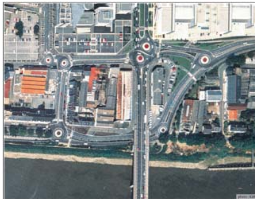
Les carrefours de l'échangeur après aménagement
