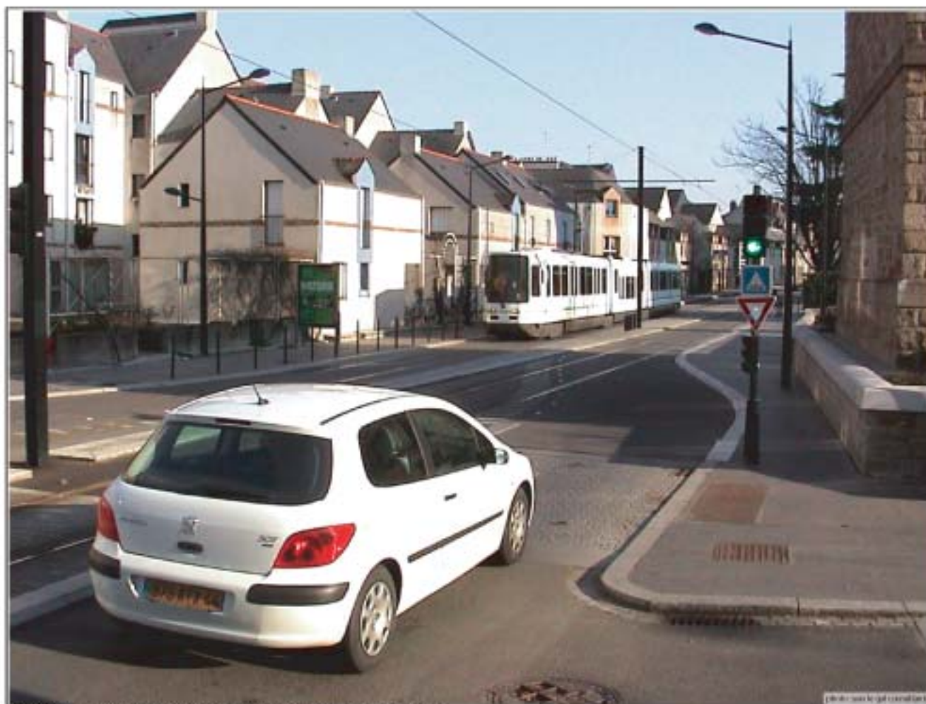
L'entrée des voitures dans la station banalisée est contrôlée par des feux
