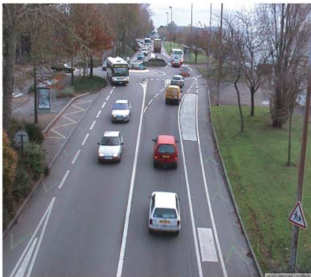
Malgré un trafic dense aux heures de pointe, la fluidité est garantie grâce aux ronds-points
