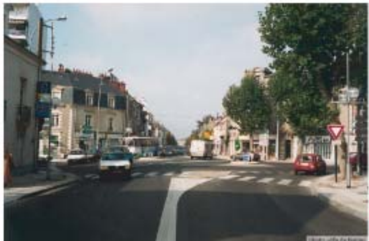
Rond-point de Rennes après aménagement
