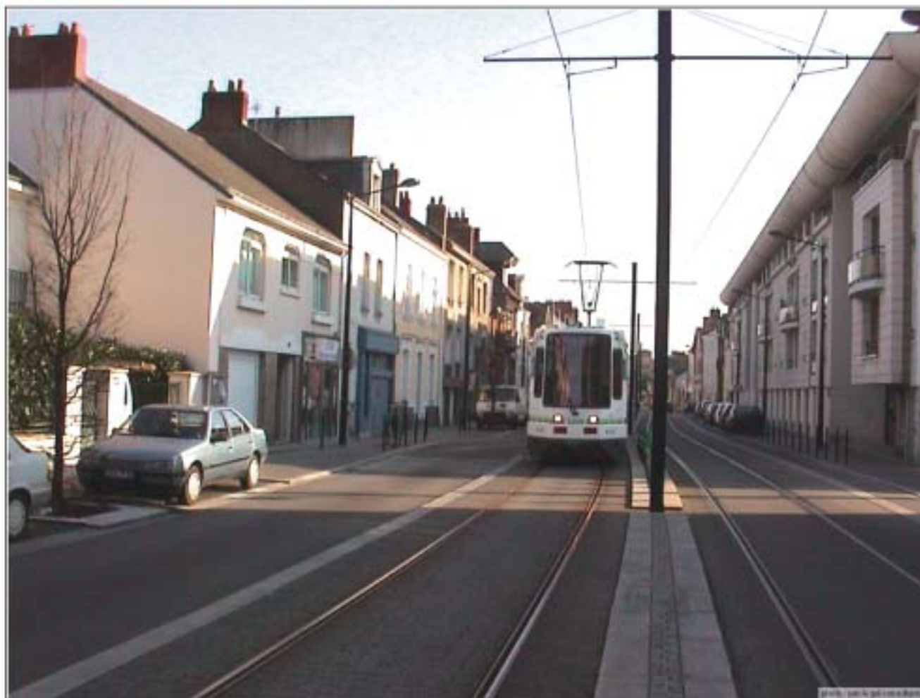
La largeur réduite de la rue des Hauts Pavés a conduit à proposer une mixité partielle tramway - circulation
