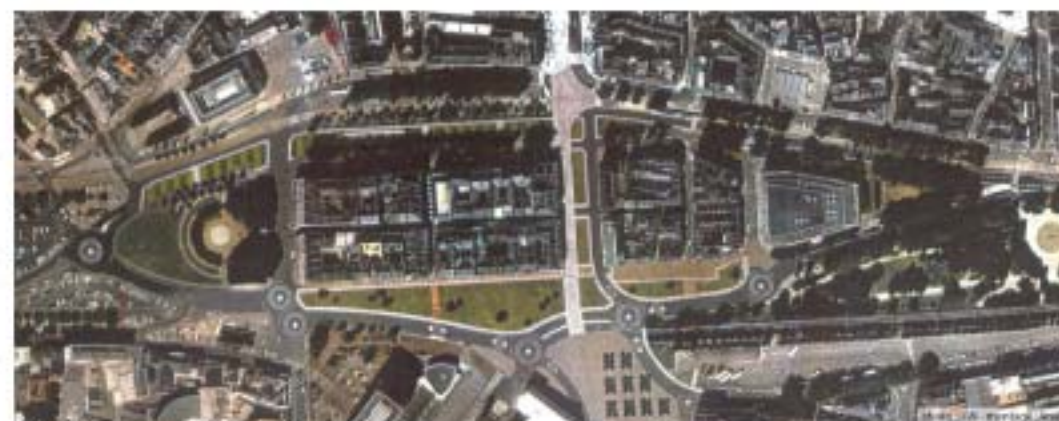
L'île Feydeau après aménagement
