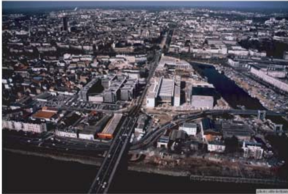
En cours de travaux
