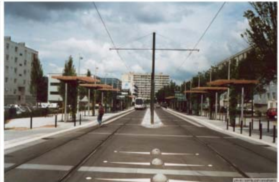
Station banalisée (ou mixte) sur la ligne 1 ouest : Romain Rolland
