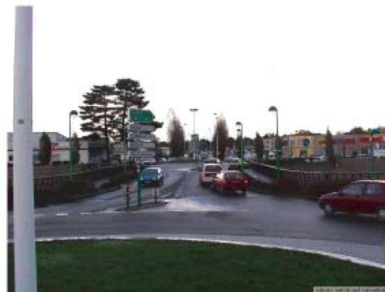
Le franchissement de la voie rapide
