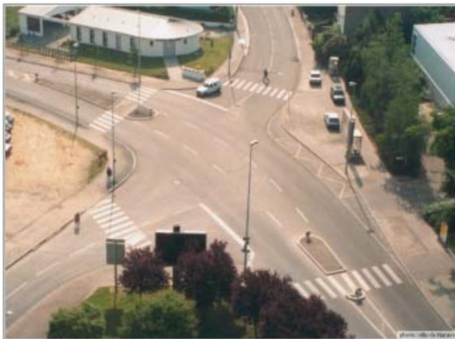
Carrefour de Port Boyer : avant aménagement
