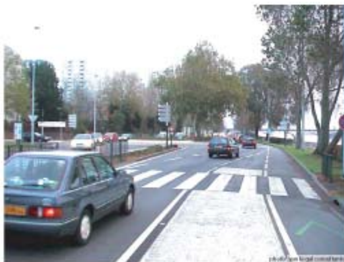
Entrée de rond-point côté Loire
