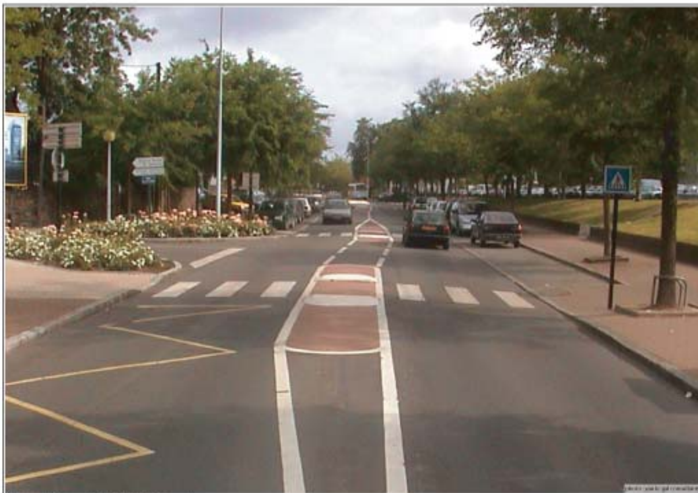
Refuges piétons sur la Route de la Chapelle
