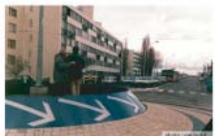
Rond-point des Thébaudières à Saint Herblain
