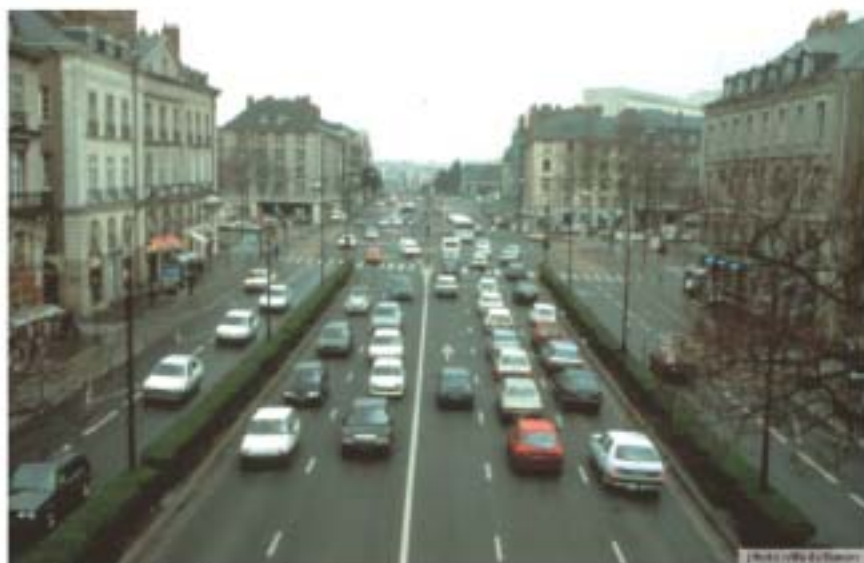
8 voies de circulation (9 au carrefour) en 1990
