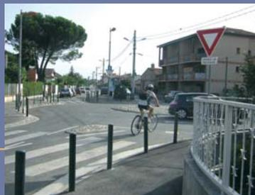
Un mini-giratoire est un carrefour à sens giratoire dont les emprises extérieures ne permettent pas la giration des grands véhicules sans chevaucher le centre du carrefour. Aussi l'îlot central d'un mini-giratoire est entièrement franchissable. Il doit néanmoins être contourné par la droite par les véhicules à faible encombrement.
